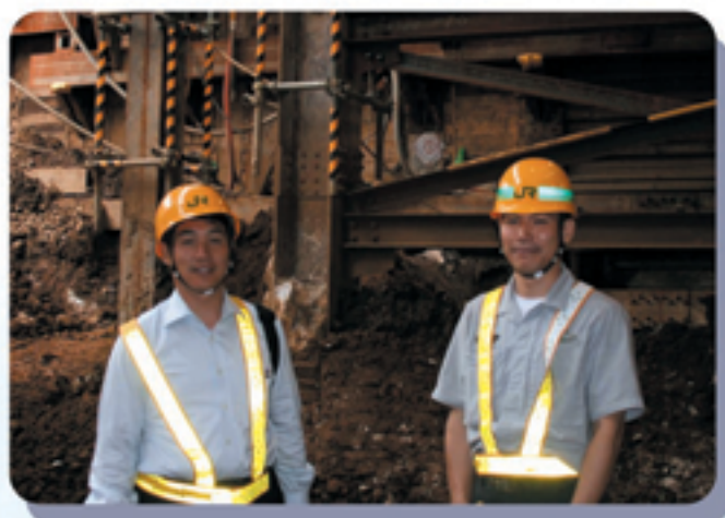
大塚駅工事を視察する。
