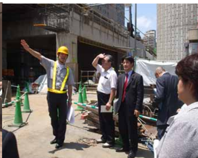
[大塚駅前広場整備の請願審査のため視察]
