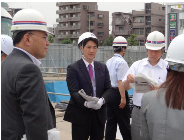
議案第 4 1 号「南長崎中央公園の整備に関する造園工事等委託契約」の審議のため現地視察。
